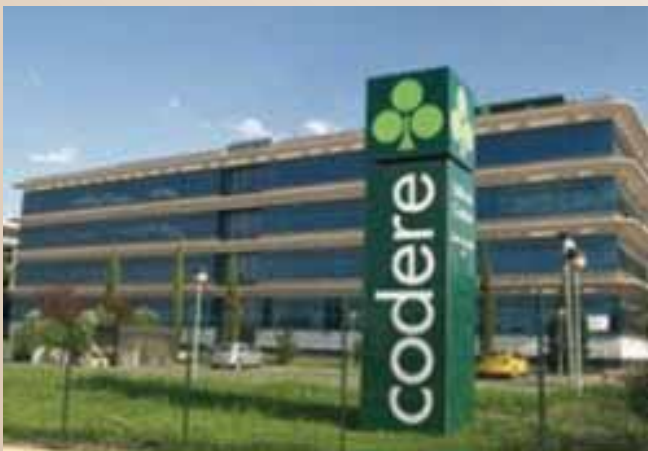
Sede de Codere en Alcobendas (Madrid)
